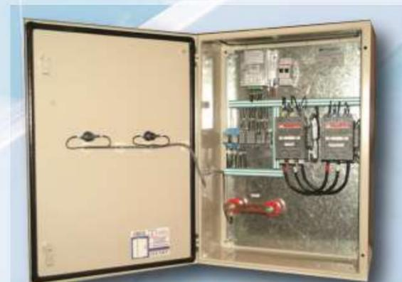
Tablero de transferencia montaje de pared
