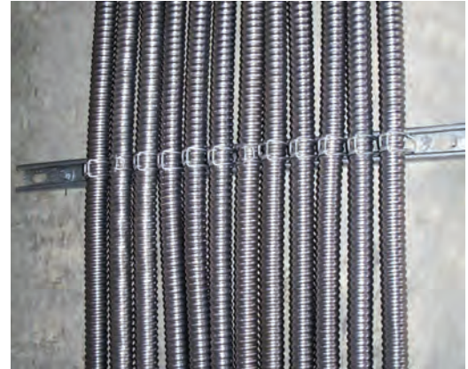
Instalaciones de cable tipo MC con soporte unicanal: En interior
