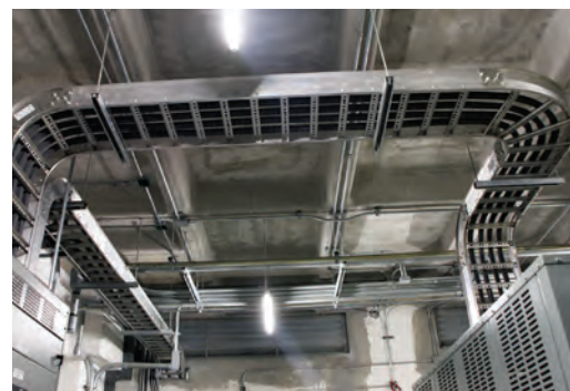
Instalación de cable monopolar tipo XHHW-2 LS en charola tipo escalera
